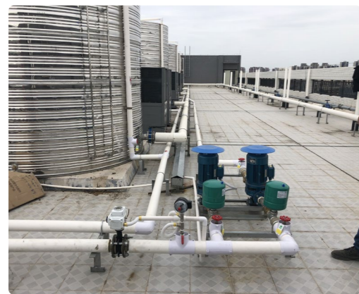
余热回收管道工程
